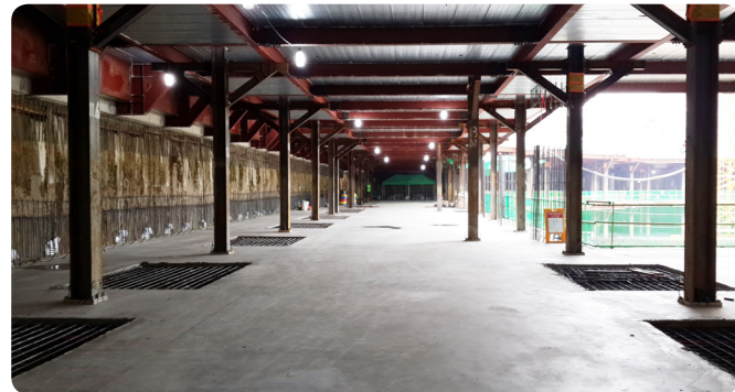
탑다운(Downward) 공사 중에는 슬래브의 하중을 철골이중보와 센터파일이 지지하면서 공사가 진행됩니다.
